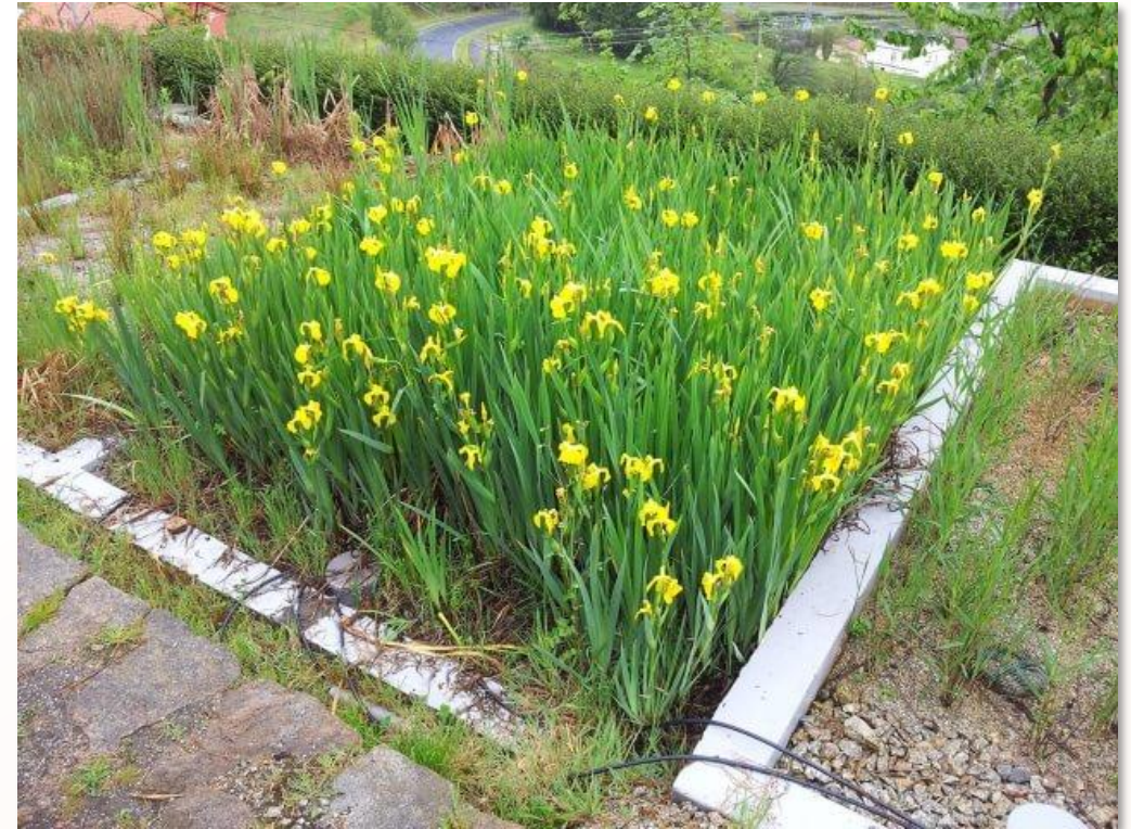
Humedal construido para tratar aguas residuales urbanas. Facultad de Ciencias, Universidade da Coruña (Galiza)
